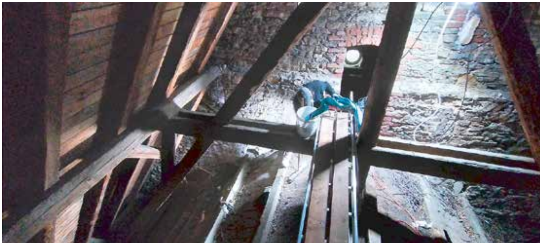
Bis in den letzten Winkel wurde der Dachboden gesäubert – das erste mal nach 130 Jahren!
